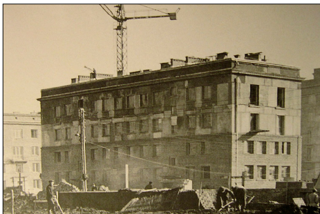
Budynek wielkoblokowy na os. A-11
