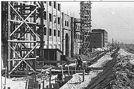
Osiedle C-1 (Teatralne) w budowie.
